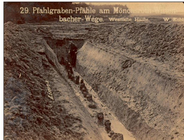
Abb. 3: Wilhelm Kohl war der Erste, der die der Limesmauer vorgelagerte Palisade nachweisen konnte und sie auch korrekt als Vorgängerbau ansprach. Hier die Pfahlreihe bei Mönchsroth, wo er seine Untersuchungen begonnen hatte. (Foto: RLK-Archiv der RGK, Kohl'sche Serie Nr. 29)
