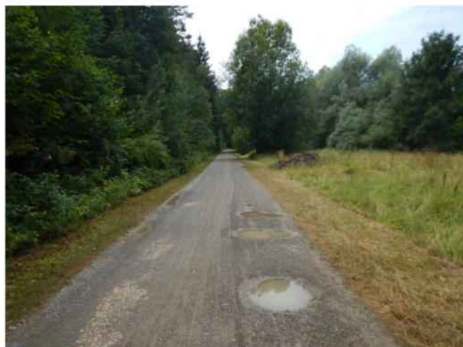
Abbildung 1, Negativbeispiel: Verdichteter Wassergebundene Decke mit Pfützenbildung und schlechter Wasserdrainage
