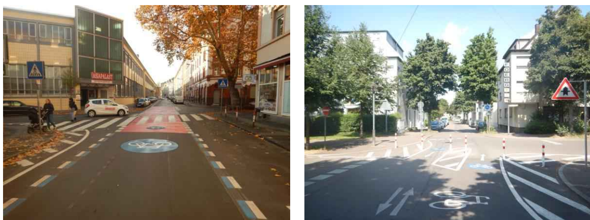
Abbildung 7: Mögliche Ausgestaltung einer Fahrradstraße mit bevorrechtigter Führung in Offenbach (links), modaler Filter in einer Fahrradstraße in Esslingen (rechts)
