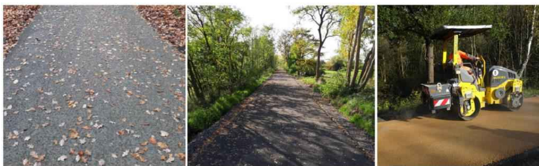
Abbildung 9: Asphaltähnliche Deckschichten aus Gemisch von Basaltstein (links) und Spezialsanden (Mitte), heller Split-Mastix-Asphalt (rechts)
