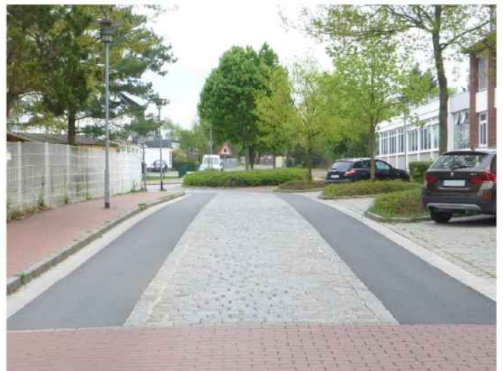
Abbildung 3: Gut befahrbarer Asphaltstreifen in Kombination mit Kopfsteinpflaster in Verden
