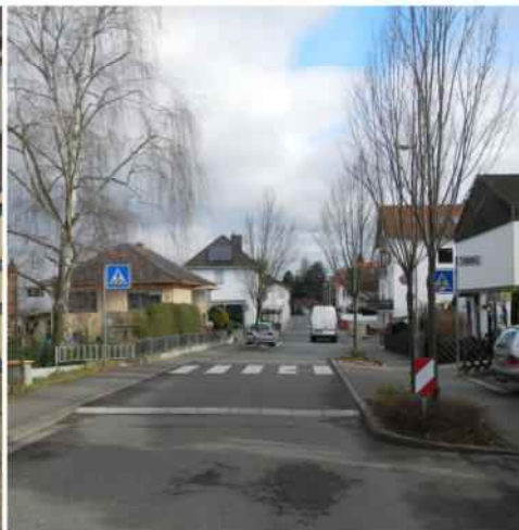
Beispiel 2: Aufpflasterung und Einengung
