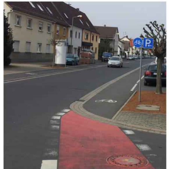
Abbildung 1: Bordsteinabsenkung Fahrbahn - Radweg, Frankfurt am Main
